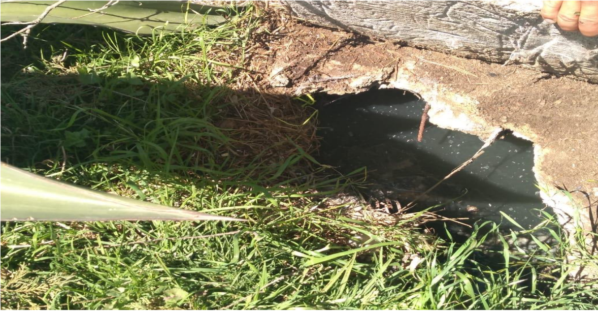
DRENAJE FRACTURADO Y EXPUESTO AL AIRE LIBRE
