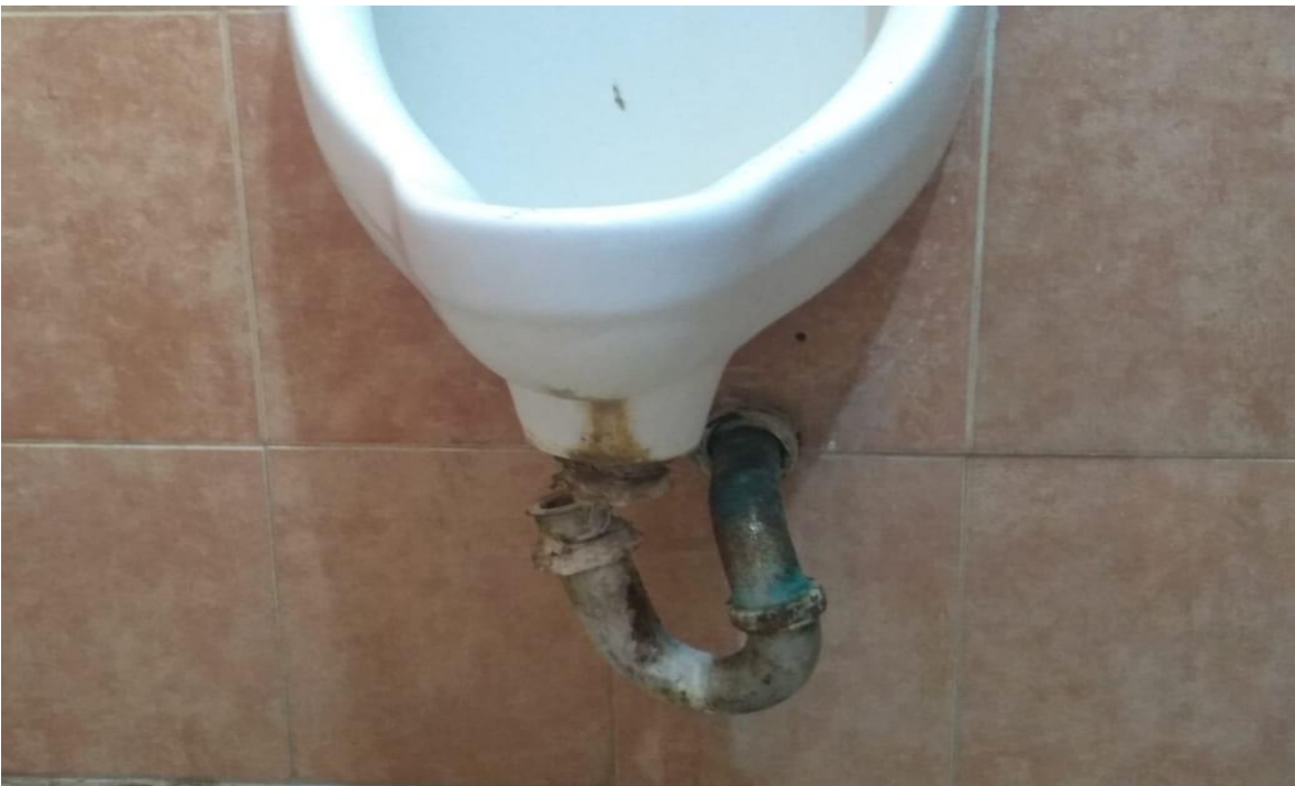
MUEBLES DE BAÑO DAÑADOS
